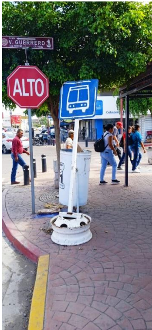
24 / 07 / 23 se retiro estructura metalica de parada de camiones se dio de baja en malas condiciones
